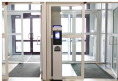
01. 주요 출입구에 S303 설치
